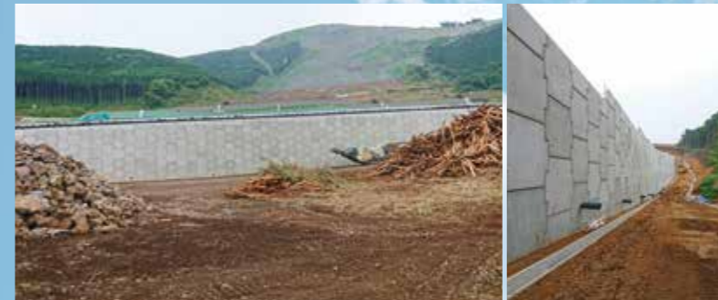
テールアルメ 熊本57号立野地区災害復旧 発注者:熊本河川国道事務所
