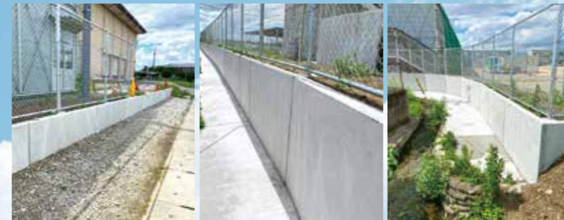
ニューウォルコン4-2型 益城中学校外構災害復旧工事 H=1200×2200 発注者:益城町役場
