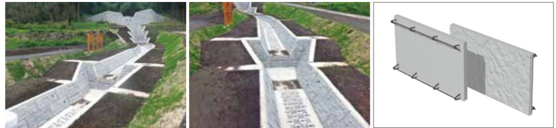
災害関連緊急砂防事業 野中川13砂防堰堤 発注者:熊本県土木部(熊本県)
