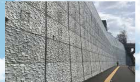
RBPウォール工法 主要地方道 熊本玉名線 発注者:熊本市 都市建設局
