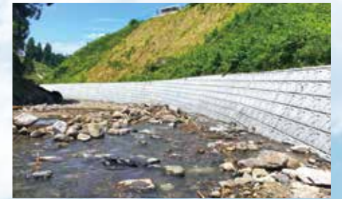
テラウォールⅡ 濁川単県砂防(熊本地震)工事他合併 発注者:熊本県阿蘇地域振興局土木部
