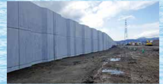
ハイブリッド防潮堤 大川河川外災害復旧工事 発注者：気仙沼土木事務所 (宮城県)
