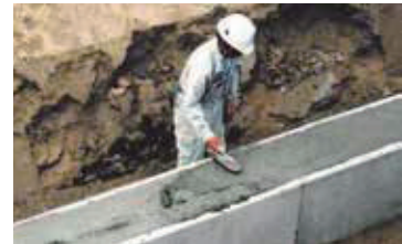
6. コンクリート均し作業
