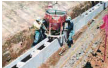
5. 中詰めコンクリート打設
